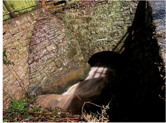
Llanfwrog culvert inlet
